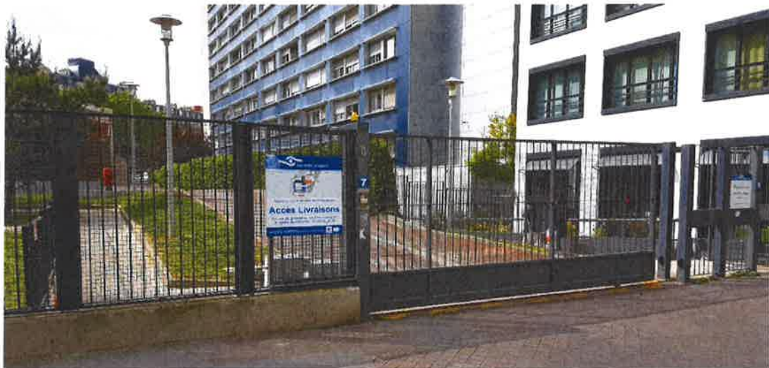
Vue de l'accès livraison actuel du CHNO depuis la rue Moreau
